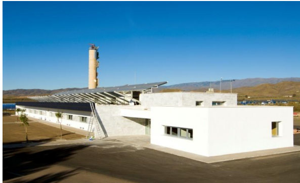
Edificio de oficinas en la PSA
