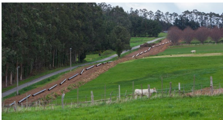
Construcción de un gasoducto en A Mariña (Galicia) GAS NATURAL FENOSA
