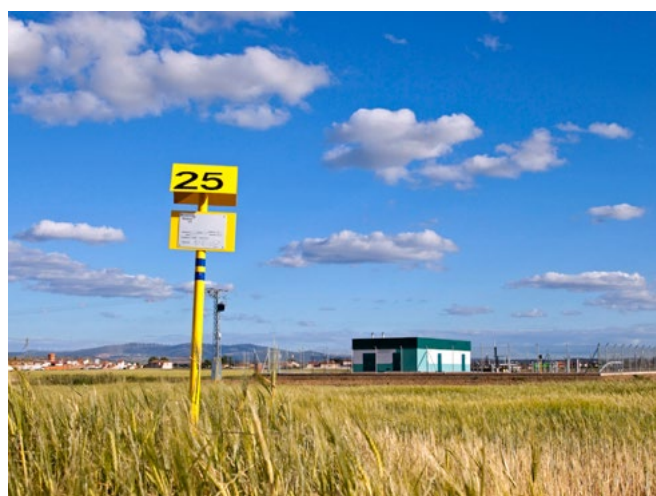
El sector del gas cuenta en España con infraestructuras de primer orden REDEXIS GAS
