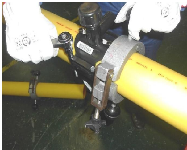
Figura 7.5. Montaje del accesorio y redondeadores
