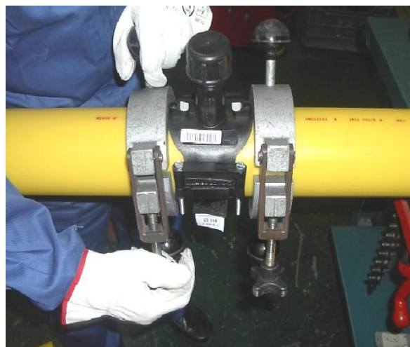
Figura 7.7. Control del tiempo de enfriamiento. Verificación de testigo
