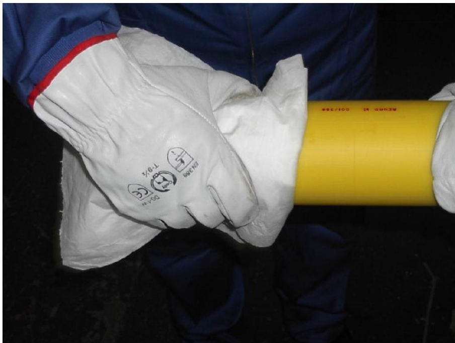
Figura 6.4. Limpieza del tubo
