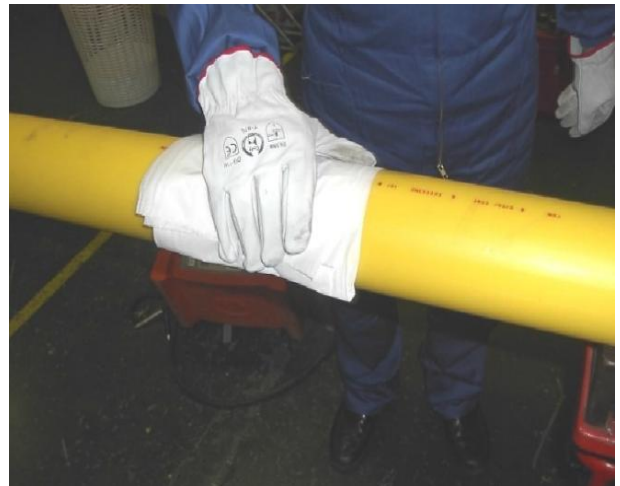
Figura 7.4. Limpieza de tubo y accesorio
