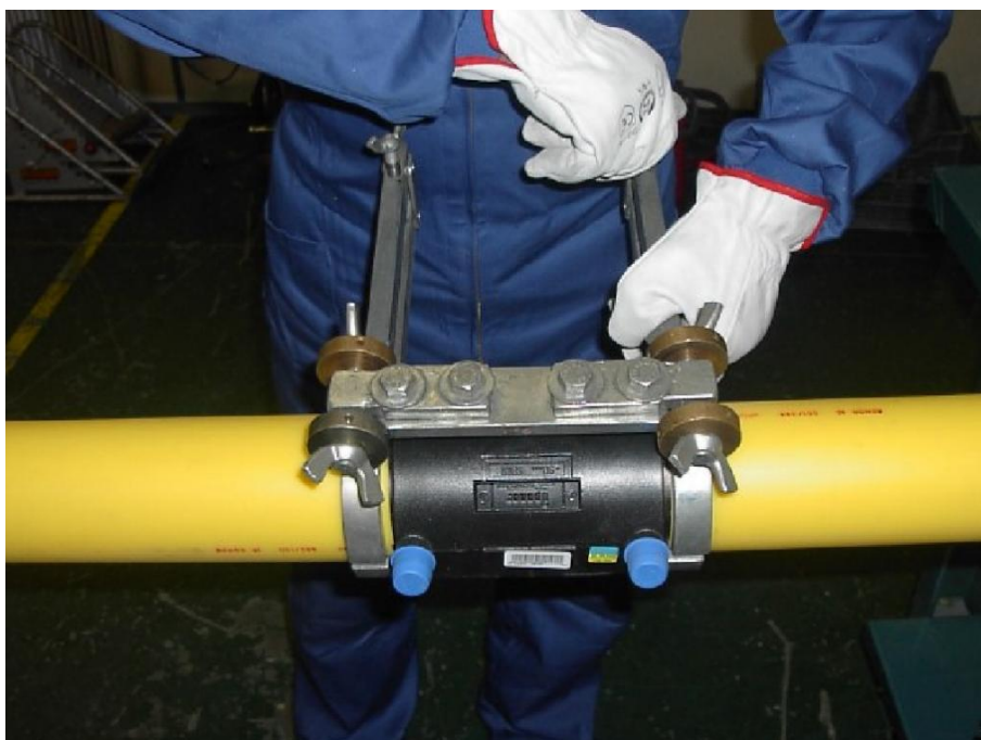
Figura 6.8. Introducción del accesorio y ajuste del alineador
