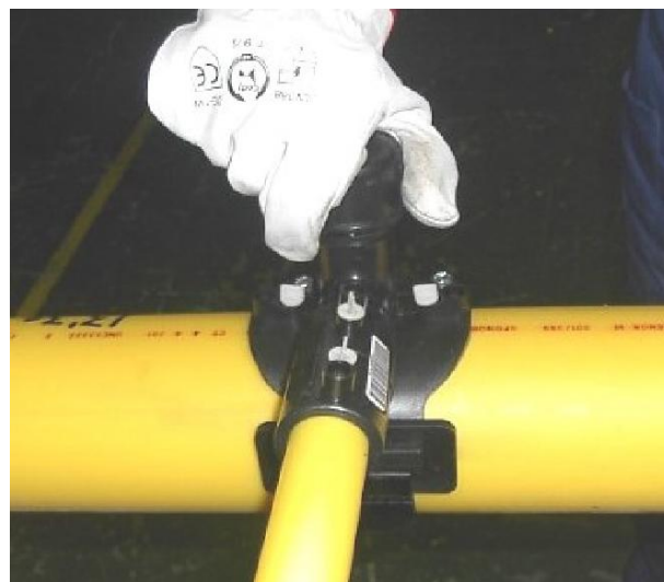
Figura 7.8. Perforación de Toma en Carga. Montaje del tapón
