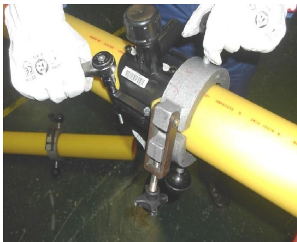
Figura 7.7. Control del tiempo de enfriamiento. Verificación de testigo
