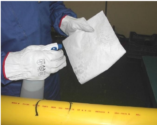
Figura 7.4. Limpieza de tubo y accesorio
