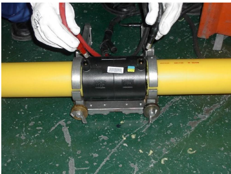
Figura 6.9. Conexión con la máquina de soldar
