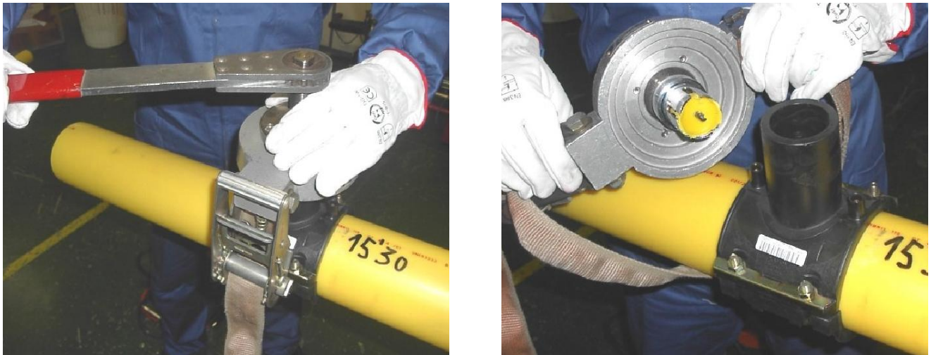
Figura 7.9. Perforación de Toma Simple
