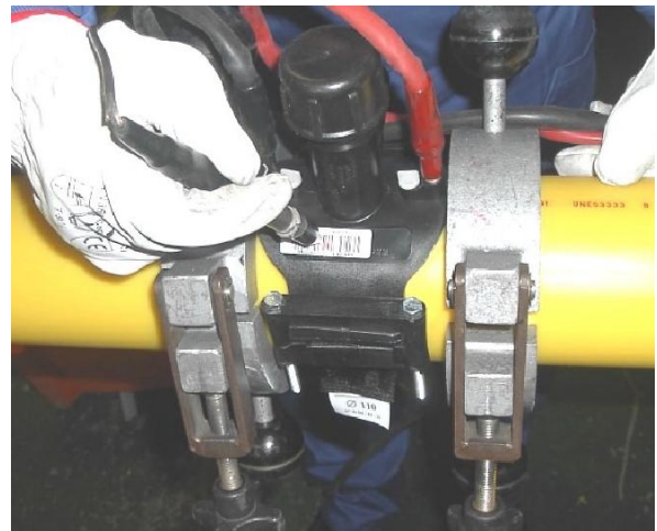
Figura 7.6. Conexión a la máquina y lectura del código de barras
