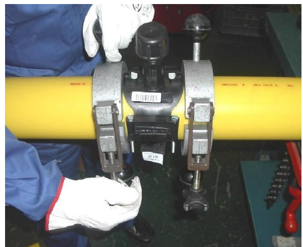
Figura 7.5. Montaje del accesorio y redondeadores
