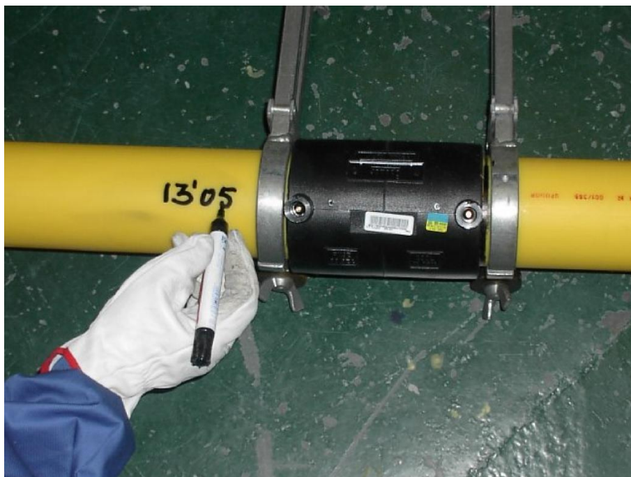
Figura 6.11. Marcado de la soldadura
