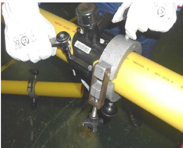
Figura 7.5. Montaje del accesorio y redondeadores
