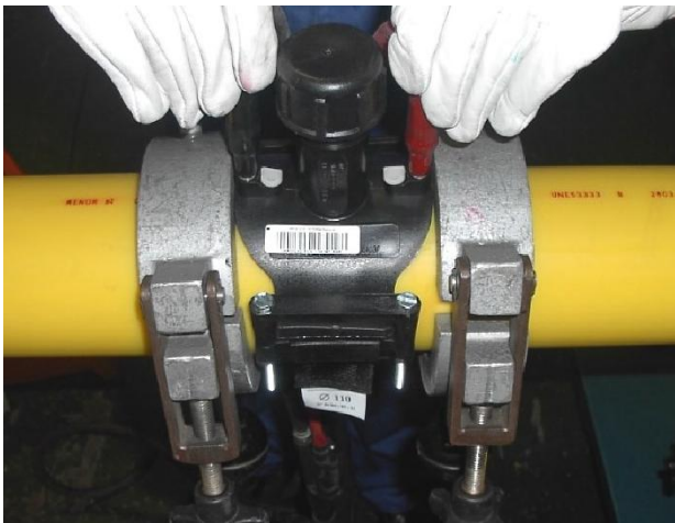
Figura 7.6. Conexión a la máquina y lectura del código de barras
