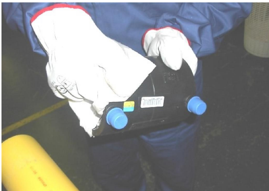
Figura 6.5. Limpieza del accesorio
