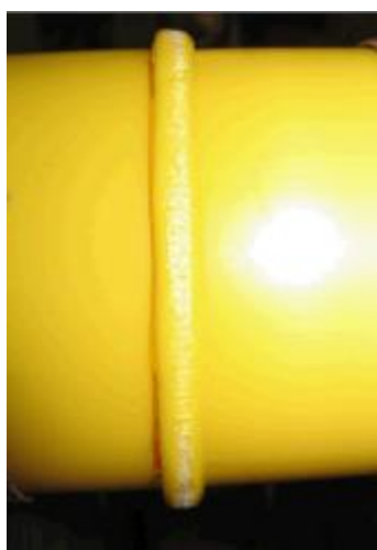
Figura 7. Cordón típico de soldadura a tope de PA-U
