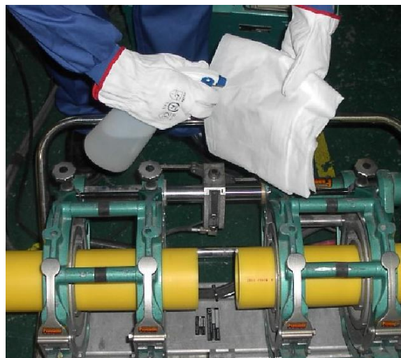
Figura 4.11. Limpieza de los tubos
