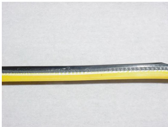
Cordón de soldadura entre tubería y accesorio de PE80. No se aprecia contaminación de la soldadura ni hendiduras de ningún tipo.
