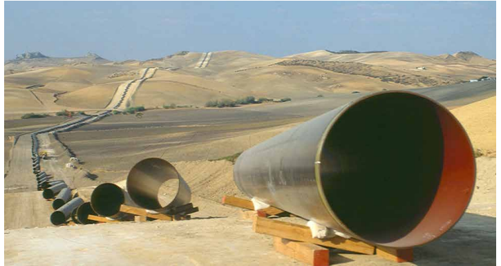
Construcción de un gasoducto
